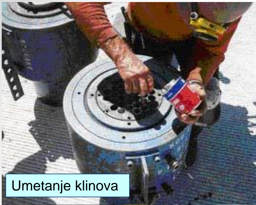
Klinovi u ankernoj ploči
