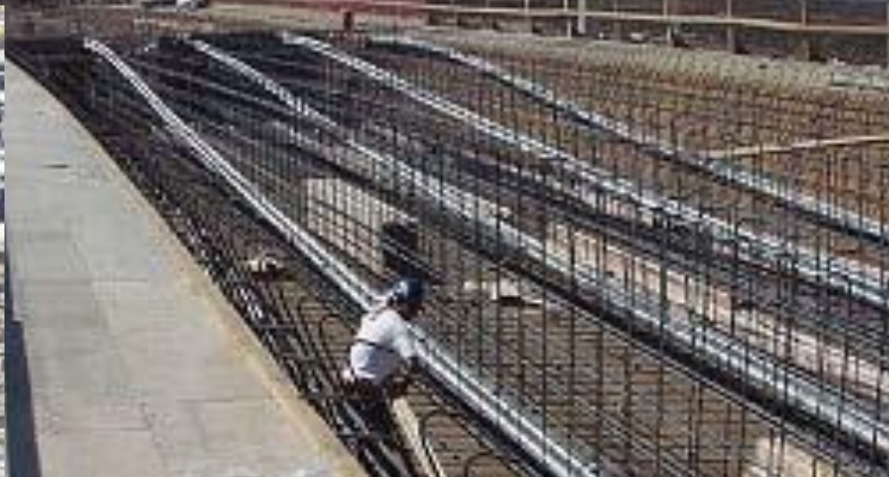
Glatke zaštitne cijevi
