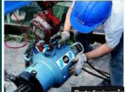
Postavljanje sidrenog bloka i klinova
