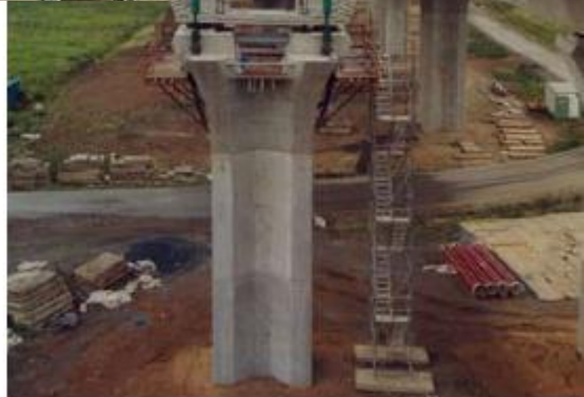
Uhřetvňovský Bridge, Pilsen, Czech Republic
